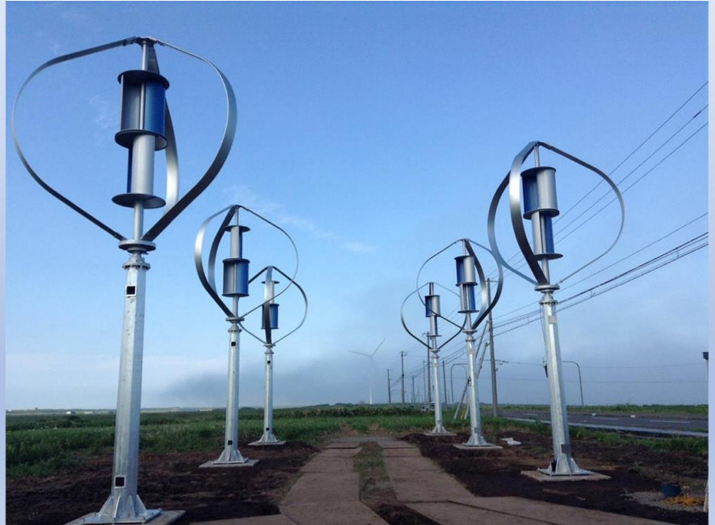
Il più grande parco «micro» eolico esistente.... realizzato da un fornitore di energia nelle aree in cui il grande eolico non era più installabile. Vicino ad un campo di girasoli per dimostrare che le installazioni di turbine eoliche non disturbano le colture, 432 turbine eoliche per 1,2 mW di energia.
